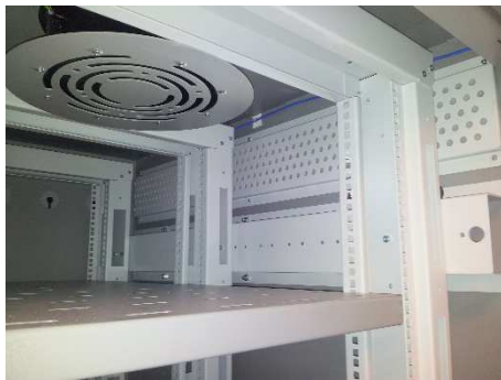
Extracteur d'air en partie Haute
