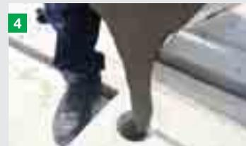
**4** Couler le mortier en flux continu d'un seul côté de la réservation
