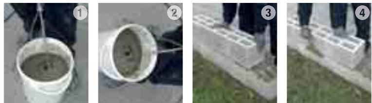
1 Préparation du mortier de montage à joint mince **Porocol Block**
