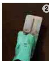
2 Après réalisation du corps d'enduit (par exemple, avec **Intomap F**), **Plastimul Pâte** s'applique à la lisseuse ou à la brosse
