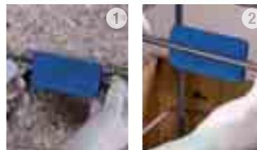
Application de **Mapeshield I** sur une structure à réparer
