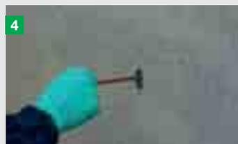
**4** Insérer le fer à béton dans le trou avec un léger mouvement de rotation afin d'évacuer l'air contenu, jusqu'au remplissage complet du trou
