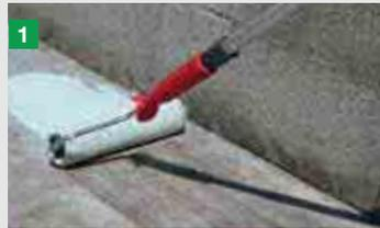
**1** Sur un support sain, propre et cohésif, appliquer 2 passes de **Primer G** diluées de moitié avec de l'eau
