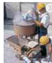
Préparation mécanique du produit avant pompage
