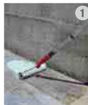
1 Sur un support sain, propre et cohésif, appliquer deux passes de **Primer G** diluées de moitié avec de l'eau
