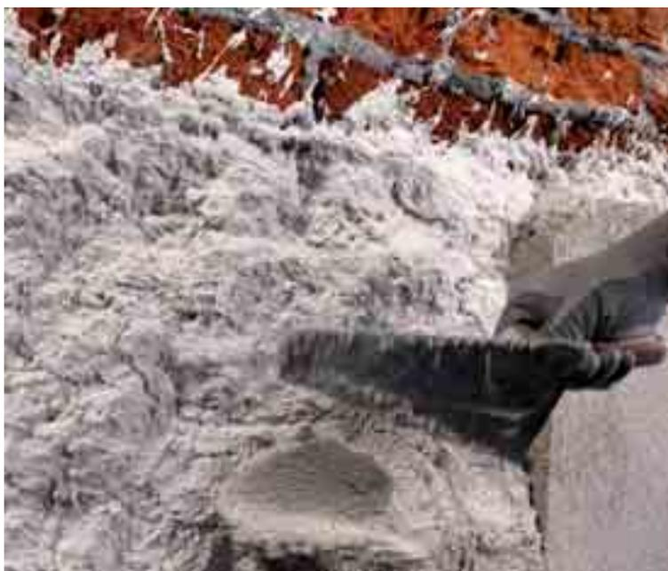
**MISE EN ŒUVRE**
