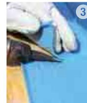
Soudure des ailes de la bande d'arrêt d'eau, en superposant légèrement les deux extrémités
