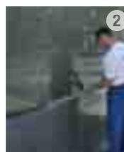
Remplissage d'un joint en façade revêtue de marbre
