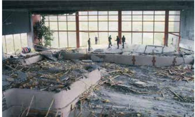
En 1985, le plafond suspendu en béton d'une piscine couverte s'est écroulé à Uster, en Suisse. Les fixations du plafond, en acier inoxydable A2, n'ont montré aucun signe de défaillance quel qu'il soit, bien que certaines soient entièrement détruites intérieurement, en raison de fissures de contrainte liées à la corrosion.
